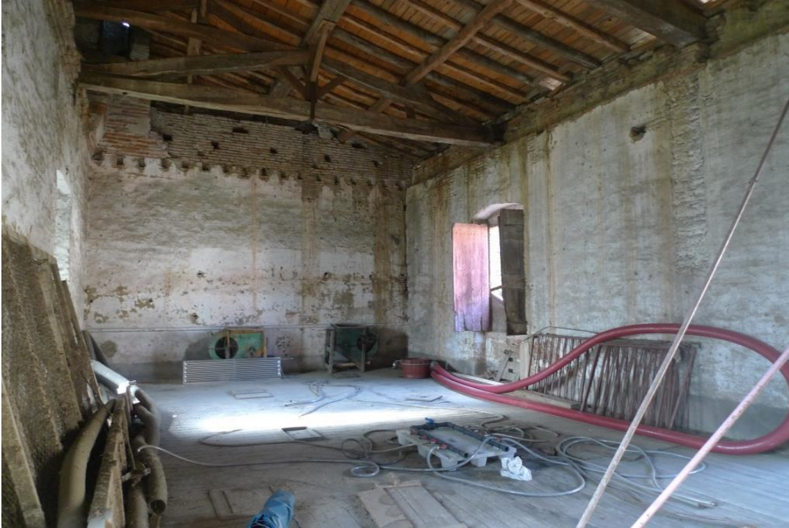
Fig. 117 : Vue de l'angle nord-est. Au fond le mur 2802, à droite le mur 2803.
