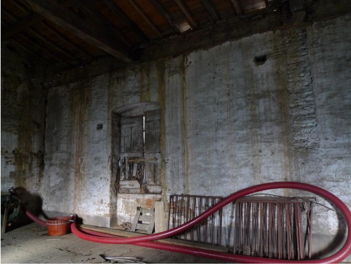
Fig. 124 : Vue du mur est 2803. A droite, le négatif d'un ancien mur.
