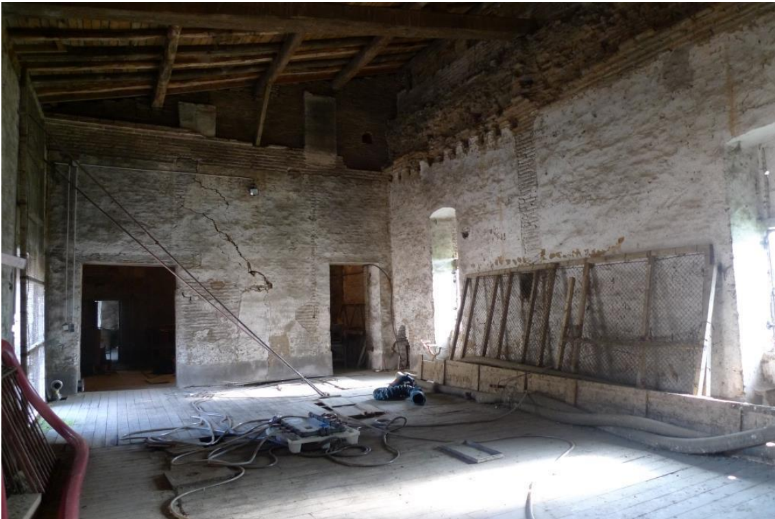
Fig. 115 : Vue de l'angle sud-ouest. A gauche le mur 2702, à droite le mur 2801.
