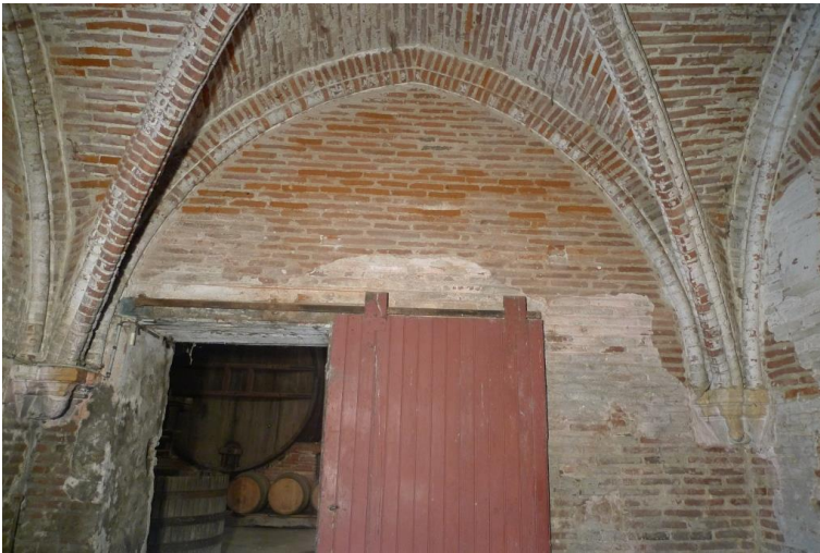
Fig. 75 : Mur ouest (1303), avec la porte 1306.
