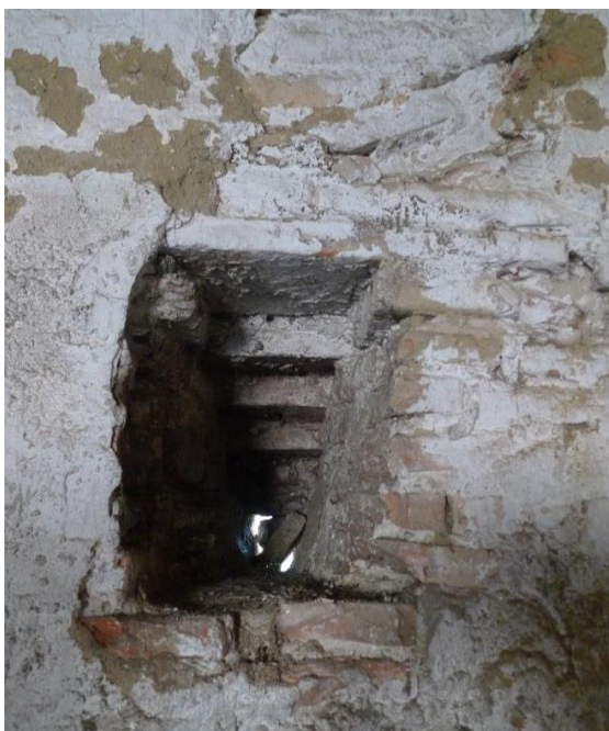
Fig. 122 : Traces d'arrachement d'un mur, évacuation des eaux de pluie et traces d'un pignon.
