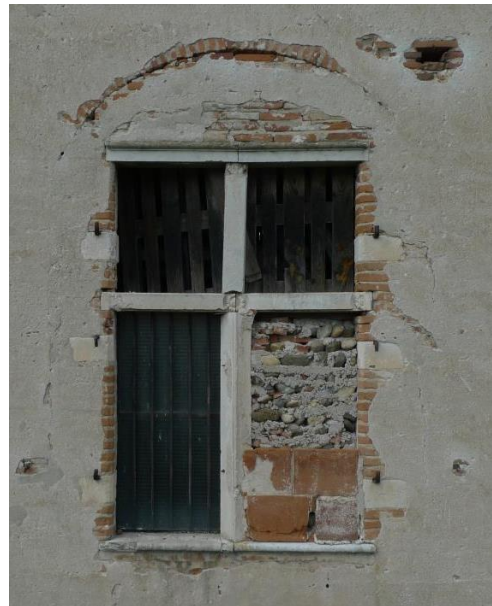
Fig. 41 : Croisée (2606) surmontée d'un arc de couverture d'une ancienne fenêtre jumelée
