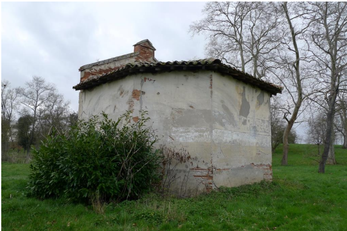
Fig. 56 : Vue depuis le sud-est : le chevet enduit, décoré de deux litres funéraires.
