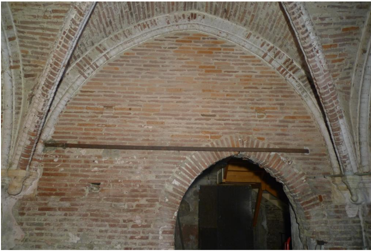
Fig. 74 : Mur ouest (1402), avec la porte 1405.
