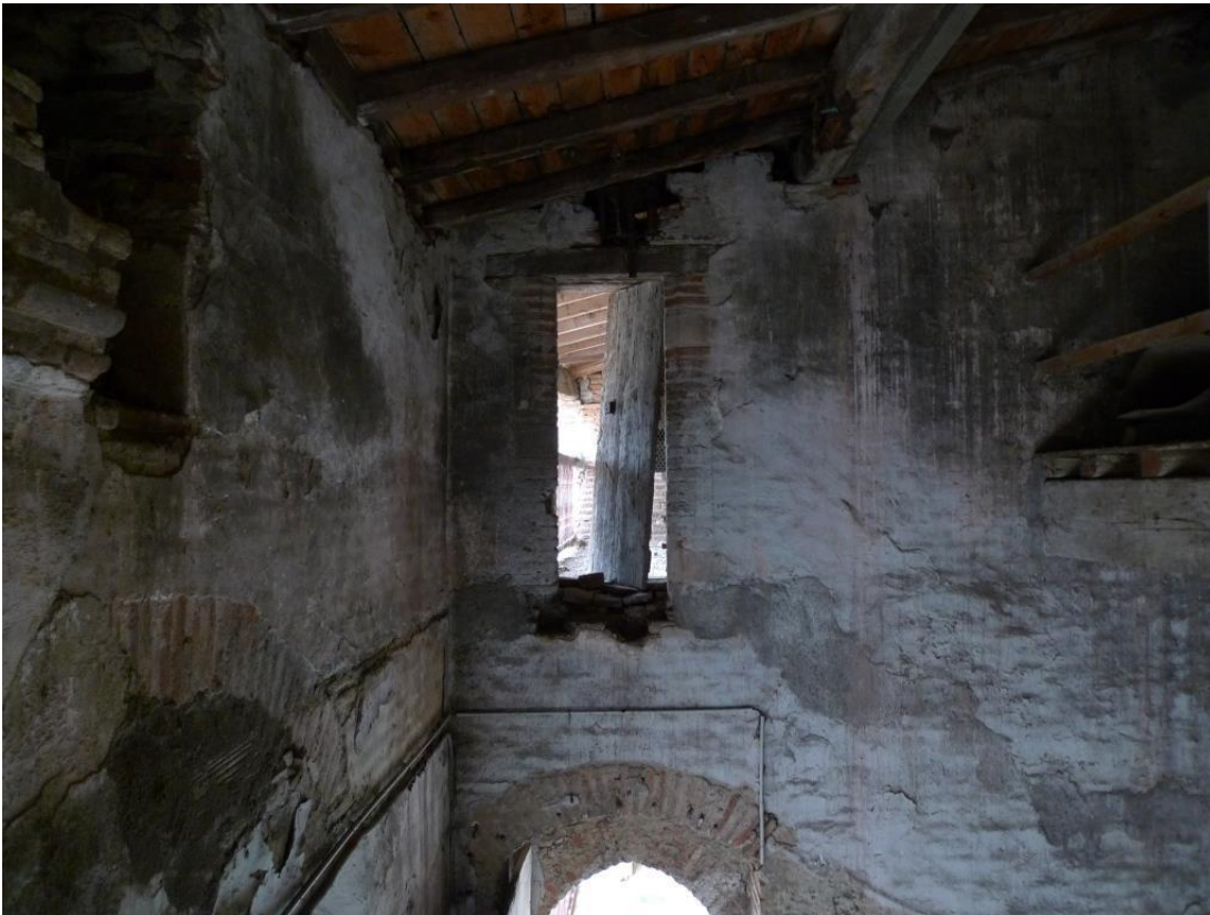
Fig. 98 : Porte dans le mur est 2402 vers la galerie supérieure GAL 36.
