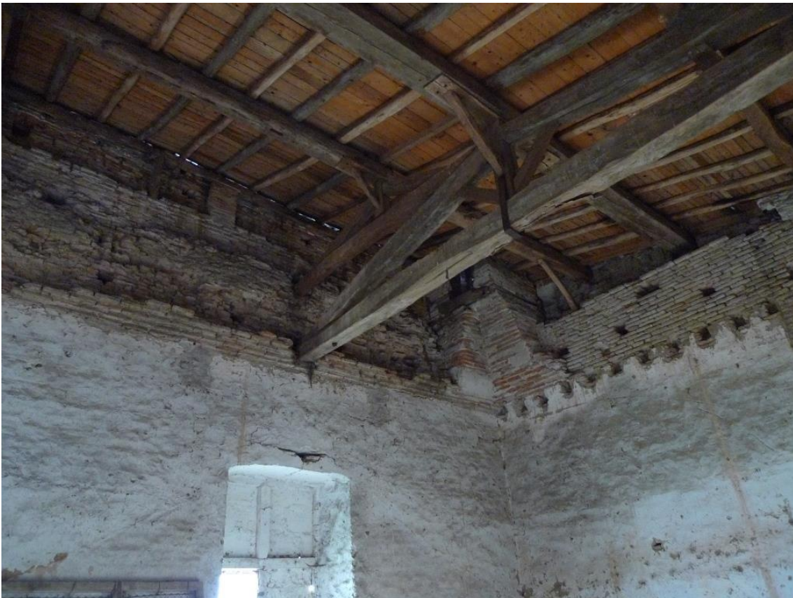
Fig. 118 : L'angle nord-ouest avec la base de l'échauguette (TUR 44).
