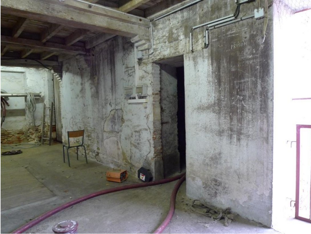
Fig. 101 : Mur nord 2603 et porte 2611 vers la pièce ouest 27.
