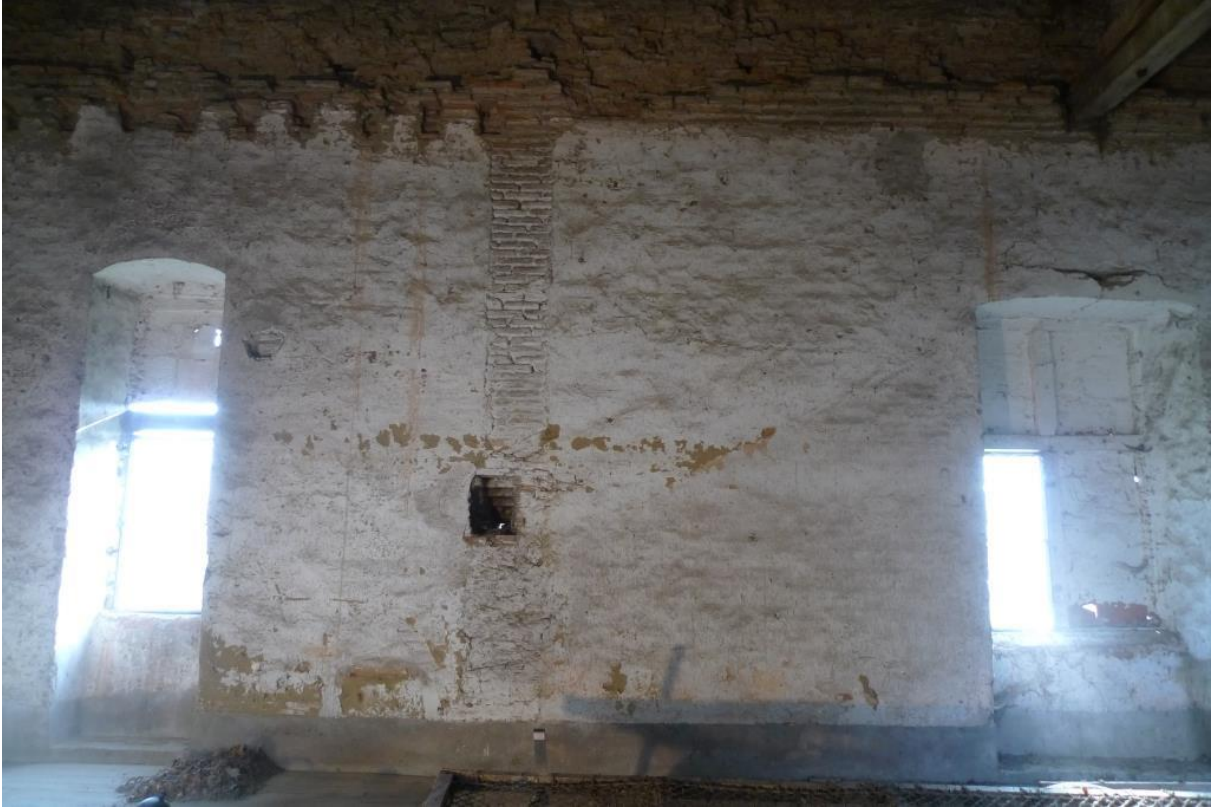
Fig. 119 : Mur ouest 2801. La trace d'arrachement d'un mur est visible au centre, et l'évacuation 2809 est connectée à la trace d'un pignon qui apparaît sous l'enduit.
