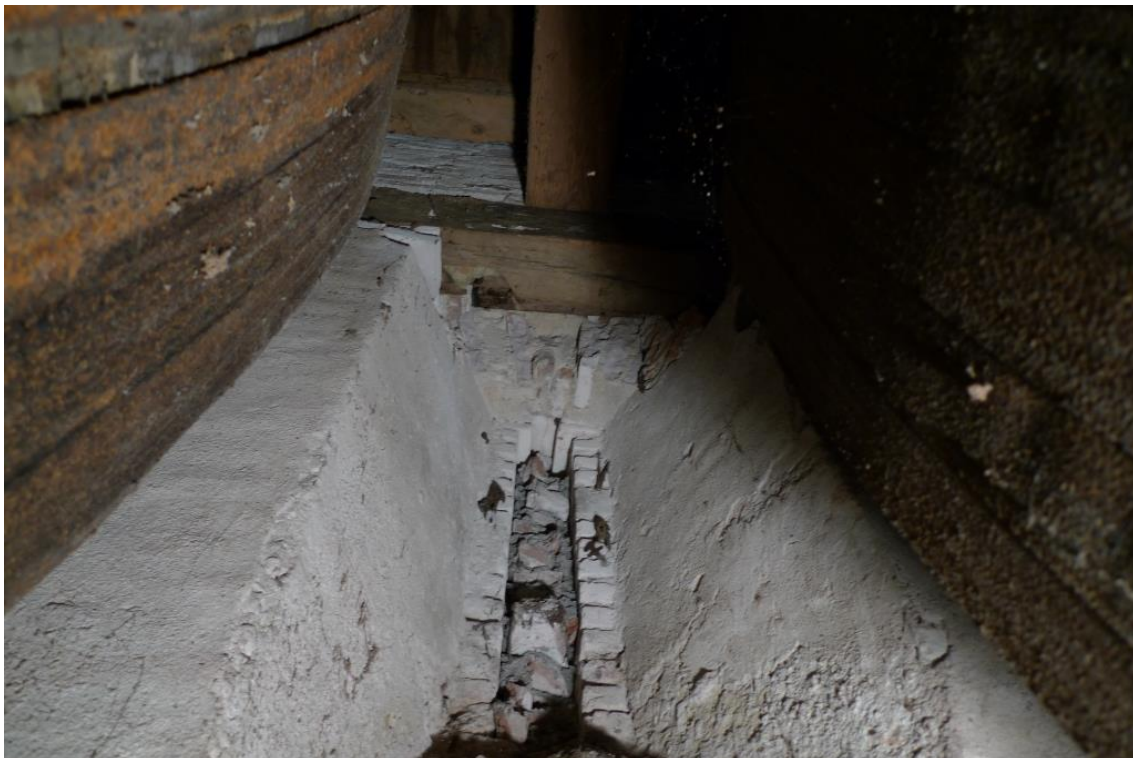
Fig. 73 : Fente de jour bouchée (JOU 1309) sur le mur est (1301).
