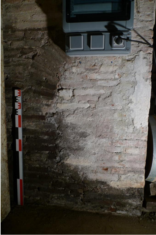
Fig. 69 : Niche 1308 (mur nord 1203)
