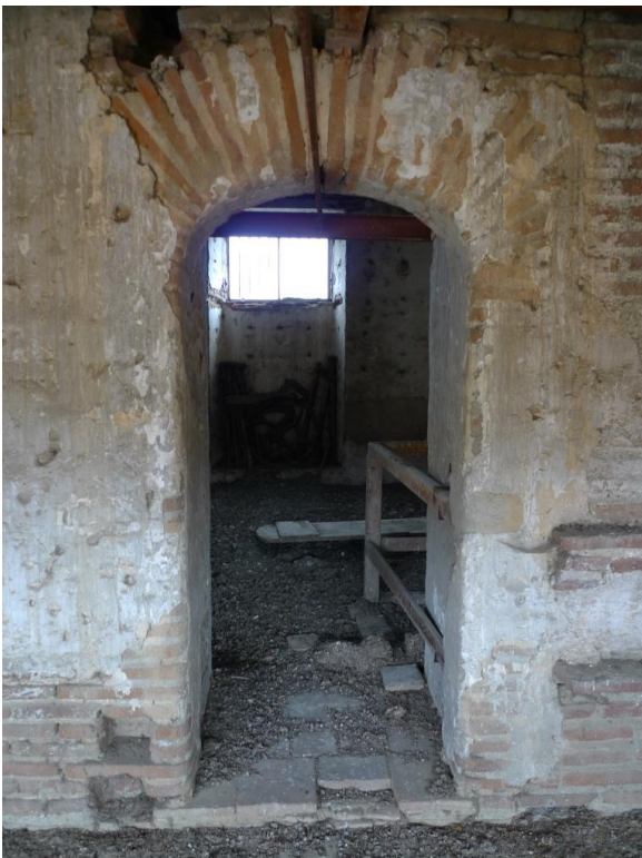
Fig. 127 : Porte du mur nord, côté galerie
