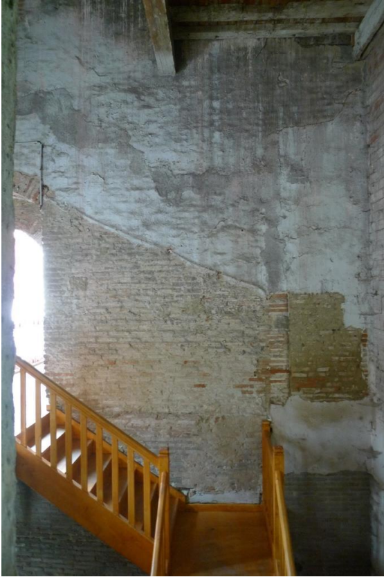
Fig. 97 : Mur est 2402 : traces d'un ancien escalier menant à la galerie supérieure GAL 36
