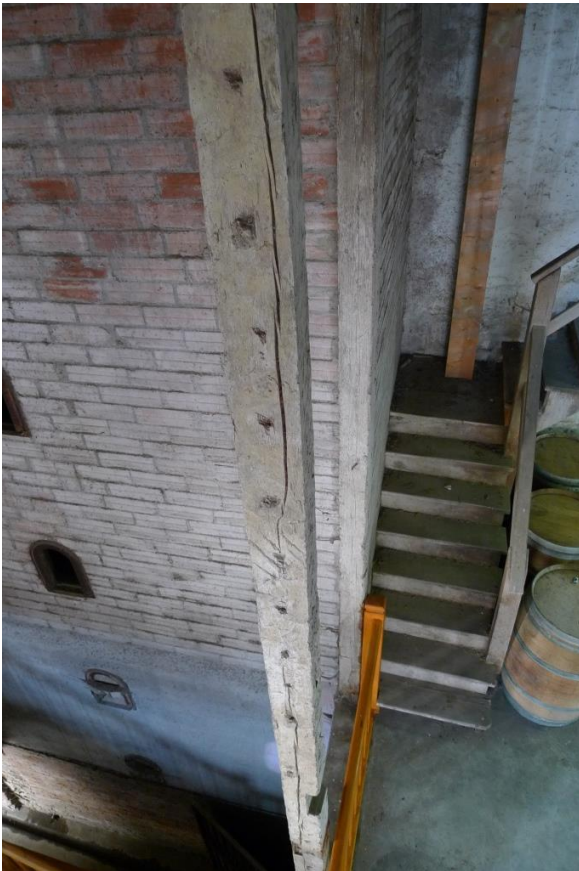
Fig. 104 : Remploi de solives d'anciens plafonds dans la structure de la mezzanine (PCE 26).
