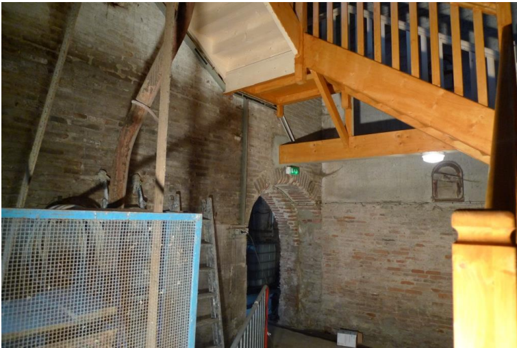
Fig. 78 : Angle sud-est (à gauche : mur 1402 ; à droite : cuve 1501).
