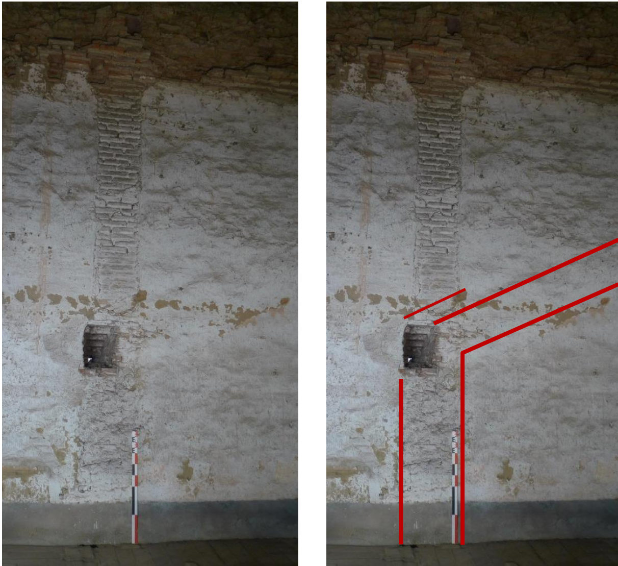
Fig. 122 : Traces d'arrachement d'un mur, évacuation des eaux de pluie et traces d'un pignon.
