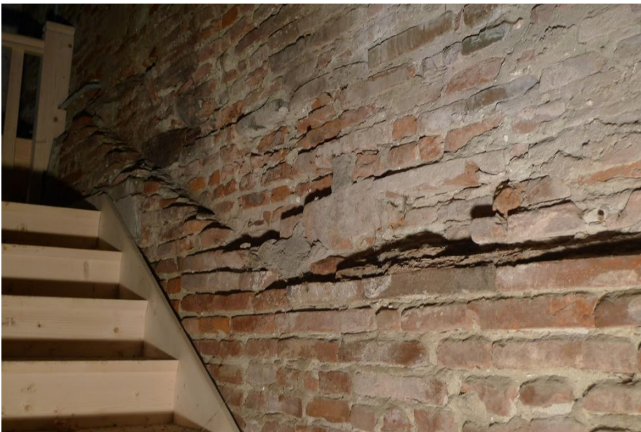
Fig. 81 : Traces de l'emplacement d'un ancien escalier contre le mur ouest (1502).
