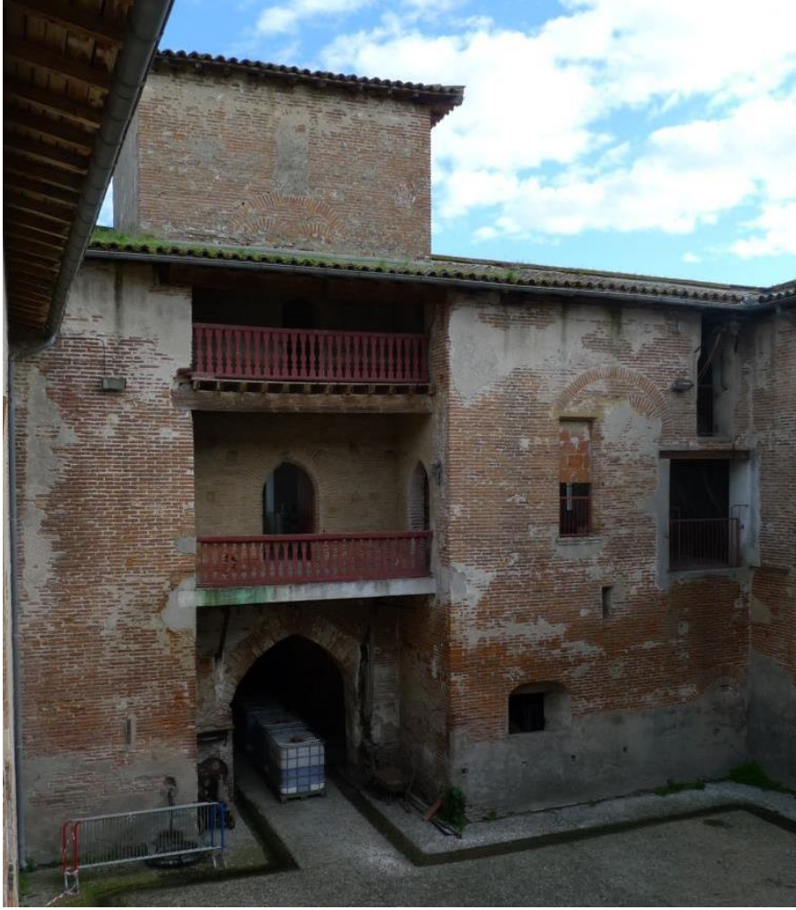
Fig. 51 : Vue générale de la façade nord de l'aile sud (FAC 1114)
