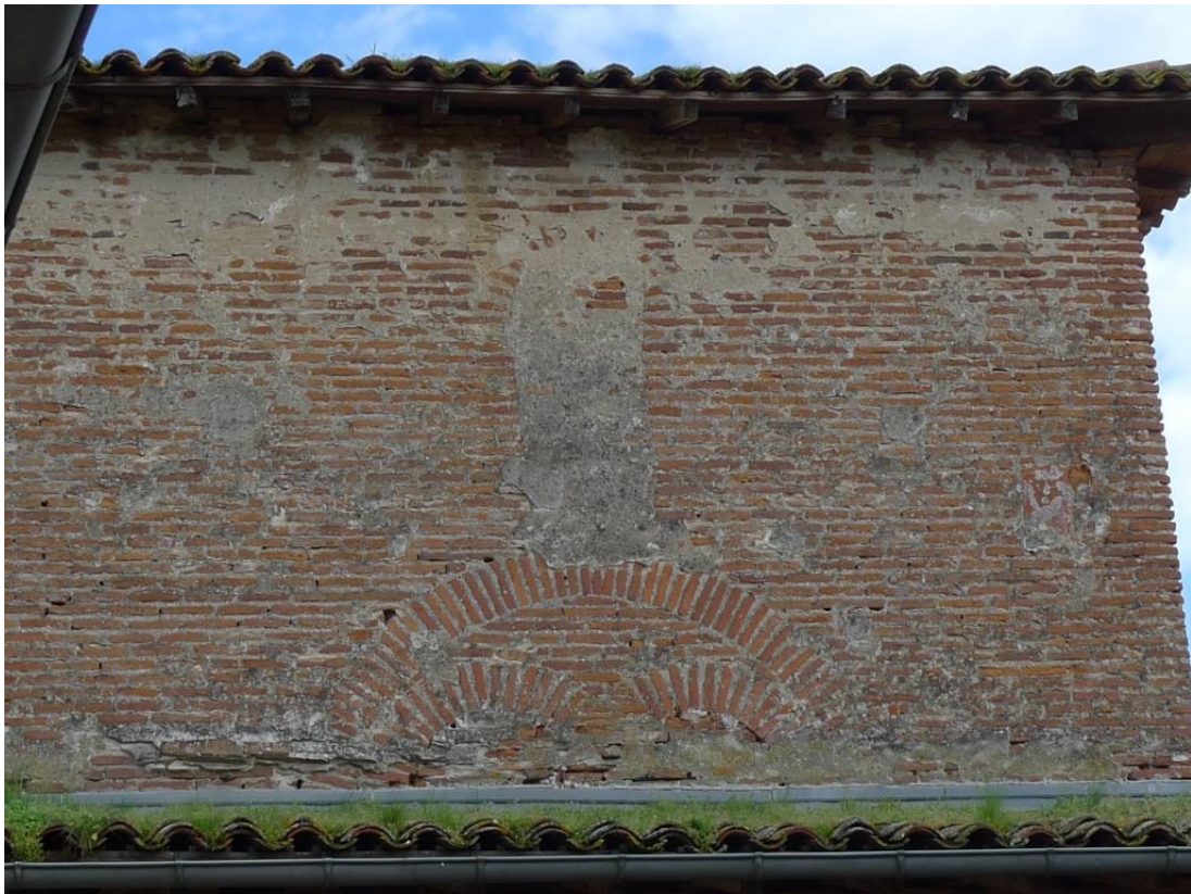
Fig. 54 : Ancienne fenêtre jumelée au niveau de la ligne de toit actuelle de la tour (TUR 45).
