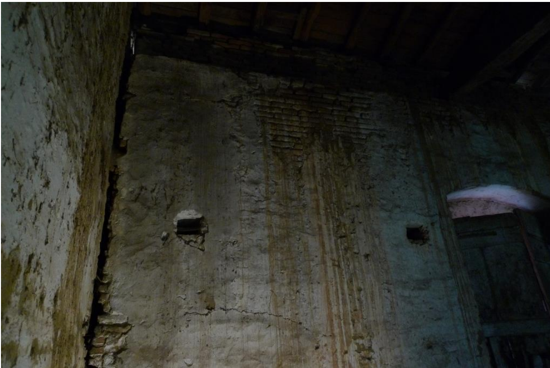
Fig. 125 : le mur est 2803 (à droite) s'appuie contre le mur sud 2802.
