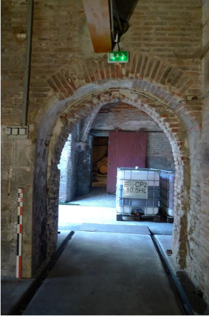
Fig. 80 : Arrière-voûture de la porte 1405.
