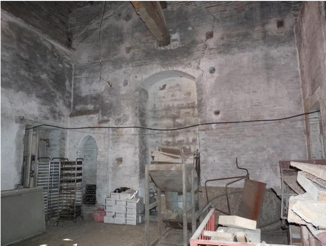
Fig. 105 : Mur ouest 2701. A gauche, le placard 2704, au centre la fenêtre bouchée 2705.
