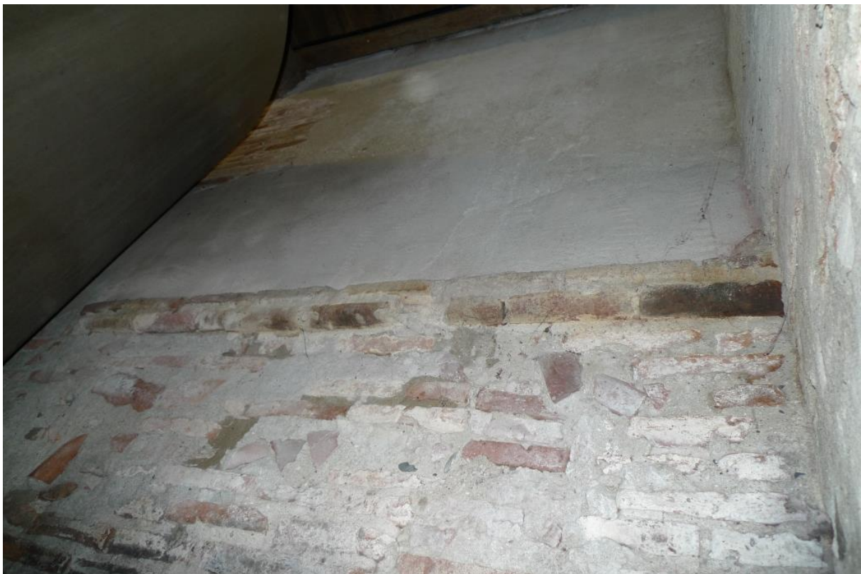
Fig. 93 : Corniche moulurée à 2,25 m du niveau actuel du sol sur le mur sud 1703.
