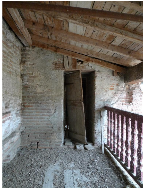
Fig. 128 : Porte du mur ouest, anciennement accessible depuis l'escalier de la pièce 25.
