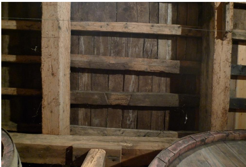
Fig. 65 : Détail d'un remploi de poutre de plafond médiéval ou Renaissance.
