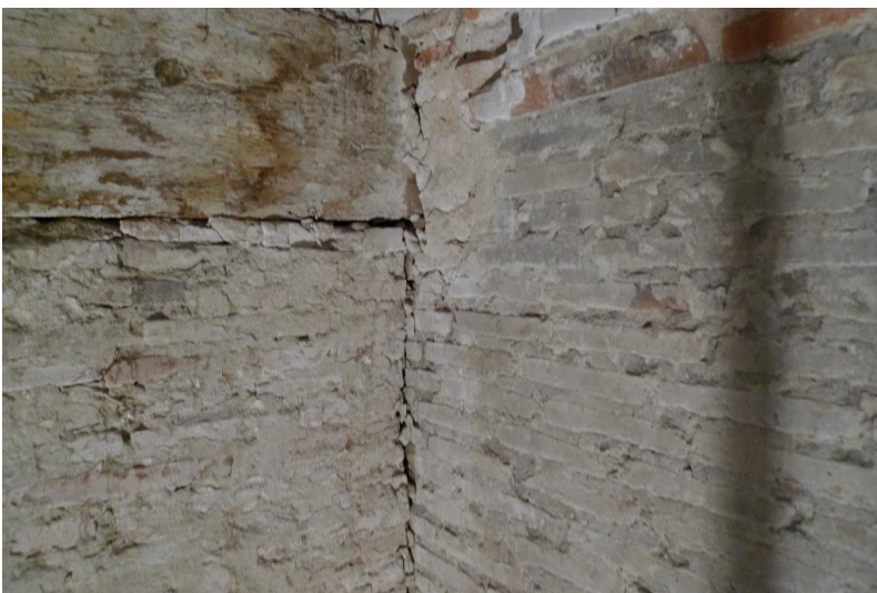
Fig. 84 : Mur ouest (1502) s'appuyant contre le mur nord (1503).
