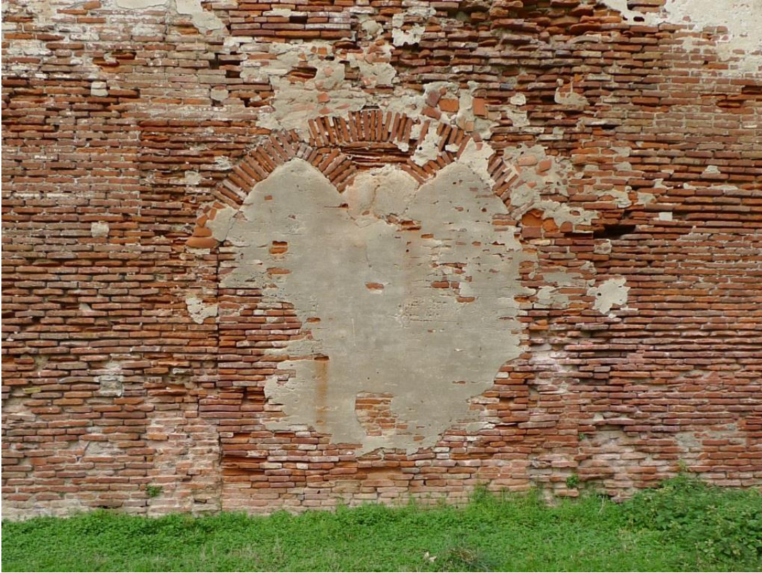
Fig. 44 : Porte jumelée bouchée vers la pièce 16.
