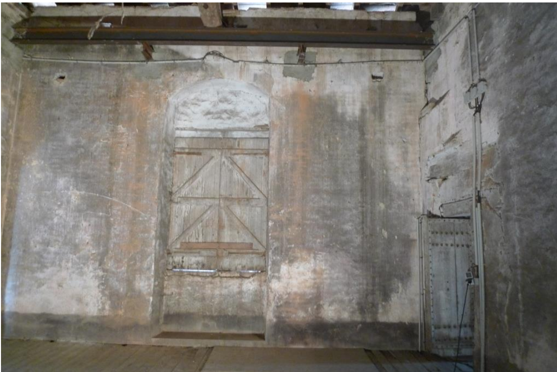
Fig. 106 : Mur est 2703. Au centre, la fenêtre 2708.
