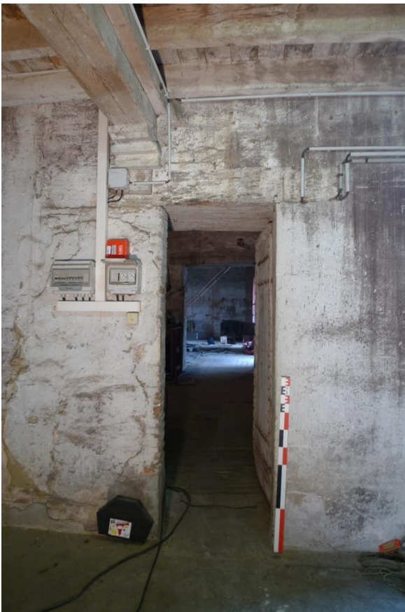
Fig. 102 : Porte 2611, partiellement bouchée à gauche/ouest
