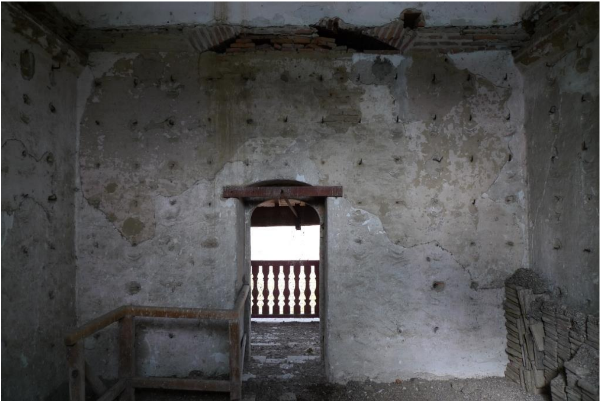
Fig. 126 : Mur nord vers la galerie 36. Au-dessus de la porte, couverture d'une ancienne fenêtre jumelée.
