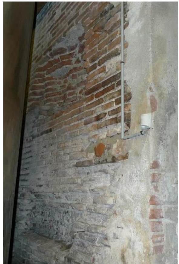
Fig. 91 : Traces de bûchage sur le mur nord 1703
