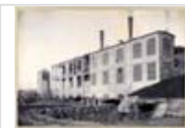
16Fi22/31 [Album de la poudrerie : bâtiment en construction]
