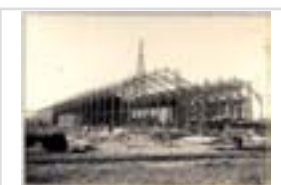
16Fi22/19 [Album de la poudrerie : construction d'un hangar]
