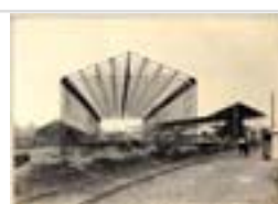
16Fi22/16 [Album de la poudrerie : construction d'un hangar]
