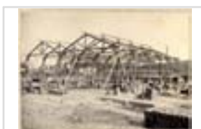
16Fi22/13 [Album de la poudrerie : construction de hangars]
