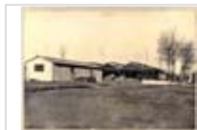
16Fi22/33 [Album de la poudrerie : hangars en construction]
