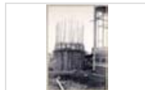
16Fi22/24 [Album de la poudrerie : construction d'un silo]
