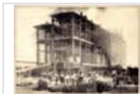
16Fi22/22 [Album de la poudrerie : construction d'un bâtiment]
