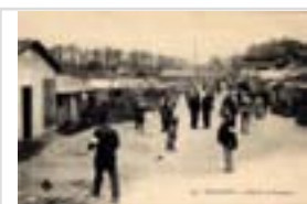
9Fi5440 139. Toulouse. Allée de la Poudrerie
