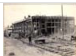
16Fi22/20 [Album de la poudrerie : construction d'un bâtiment]
