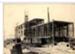
16Fi22/12 [Album de la poudrerie : construction d'un bâtiment]
